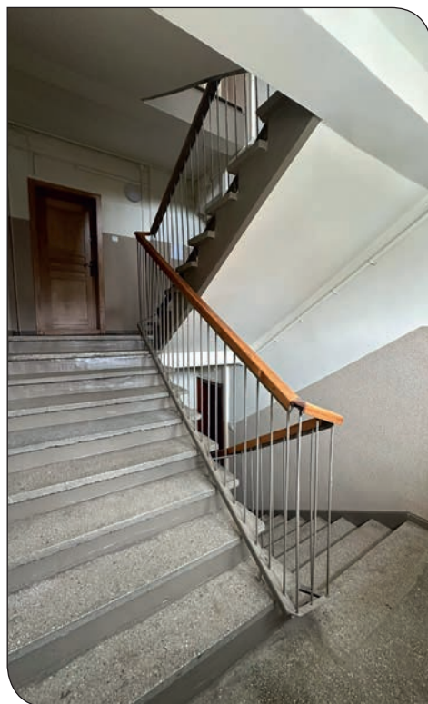
ul. Osiedlowa 4 po remoncie
