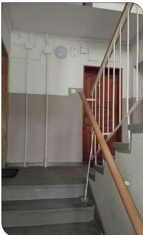
os. Błękitne 3 po remoncie klatki schodowej
