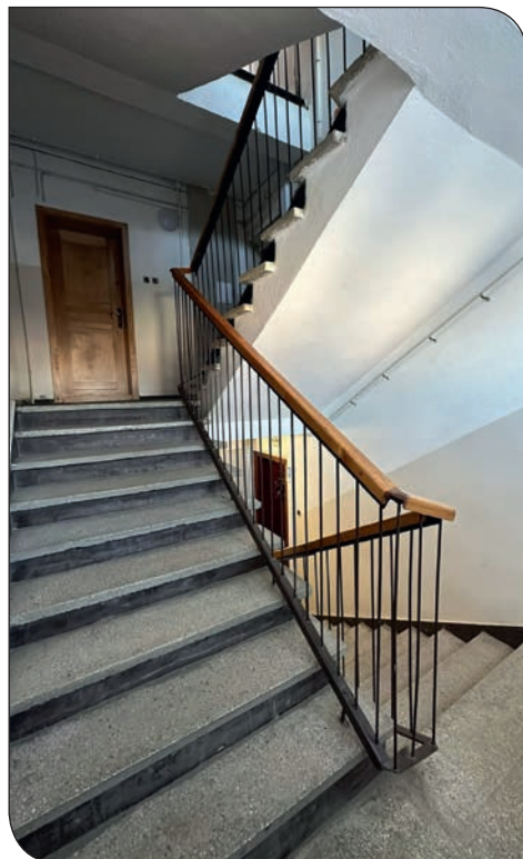
ul. Osiedlowa 4 przed remontem
